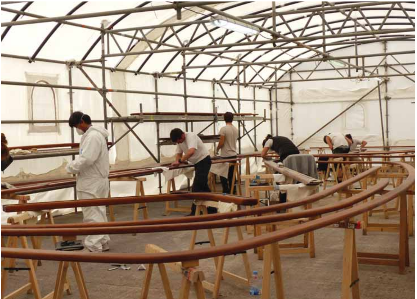
El trabajo de carpintería ha sido laborioso y meticuloso. / Fine carpentry work was meticulously carried out.
